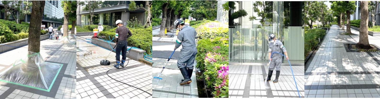
①養生作業 ②初期洗浄 ③液剤塗布 ④仕上げ洗浄 ⑤施工完了
