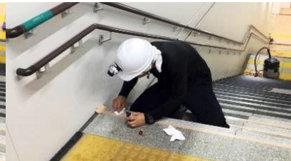
④プライマー塗布(オープンタイム10分)
