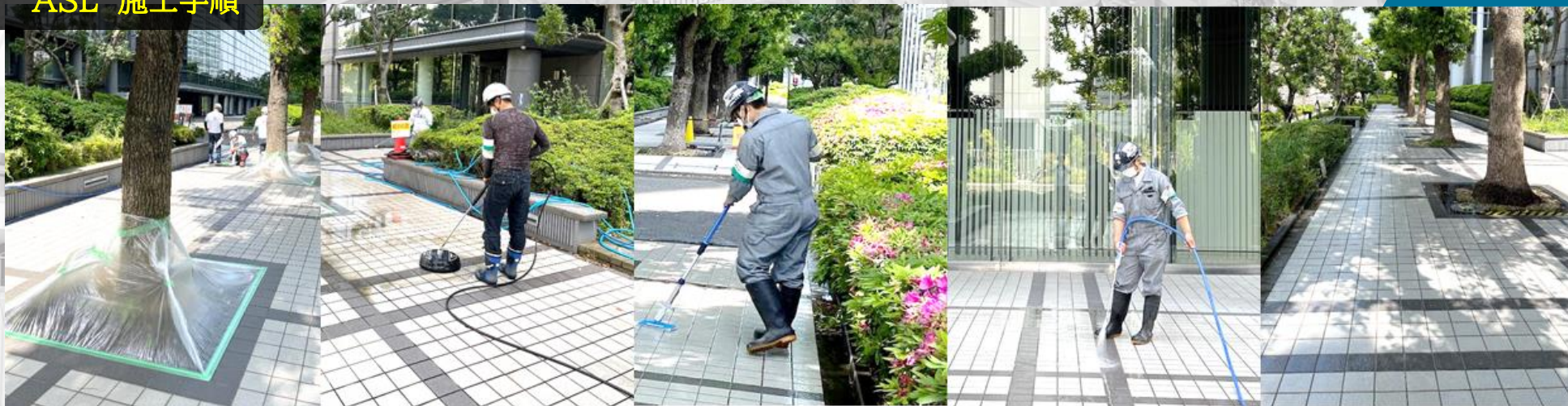
①養生作業
